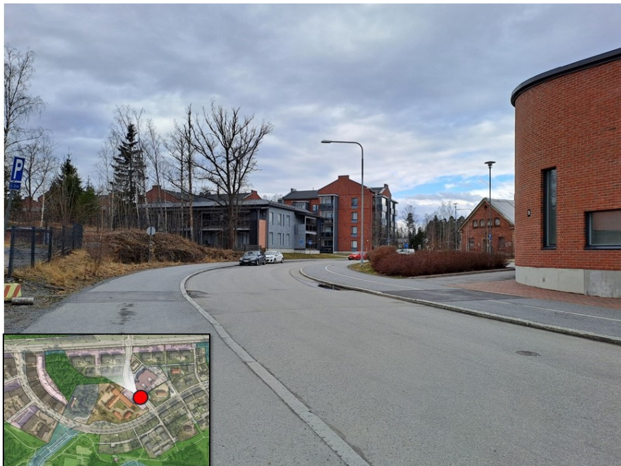
Kuva 28 Valokuva Matilda Niemen katua pohjoiseen. Kaava-alue ja Niemen kartanon navetta jää kuvan vasemmalle puolelle. Suoraan edessä tien vasemmalla puolella on 2010-luvun lopussa valmistuneita asuinrakennuksia. Kuvan oikealla puolella näkyy punatiilisen, vuonna 2014 valmistuneen, päiväkodin pyöreää kulmaa. Päiväkodin takana on punatiilinen harjakattoinen Niemen kartanon alueen sauna. Kartta esittää valokuvan ottopaikan ja suunnan.
