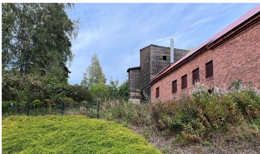
Kuva 22 Niemen mylly ja sen puurakenteinen laajennusosa kuvattuna etelän suunnasta kuvattuna kesällä 2024.
