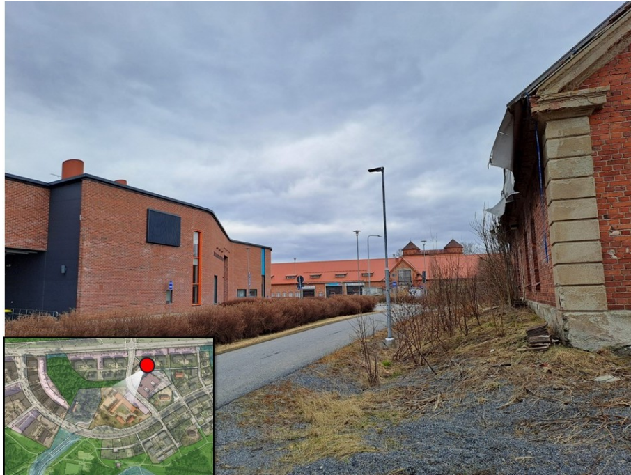
Kuva 31 Valokuva päiväkodin ja Niemen kartanon alueen saunarakennuksen välistä Puuputkenpolulta kohti kaava-aluetta ja Niemen navettaa. Kartta esittää valokuvan ottopaikan ja suunnan.
